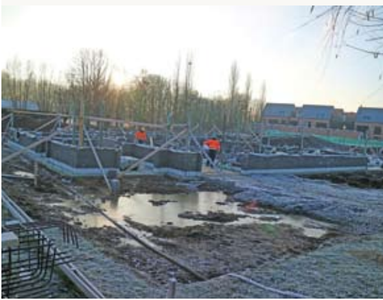
Zevenbergen start de vernieuwbouw fase 1 op. Er komt een nieuw woonerf rond de kindboerderij.
