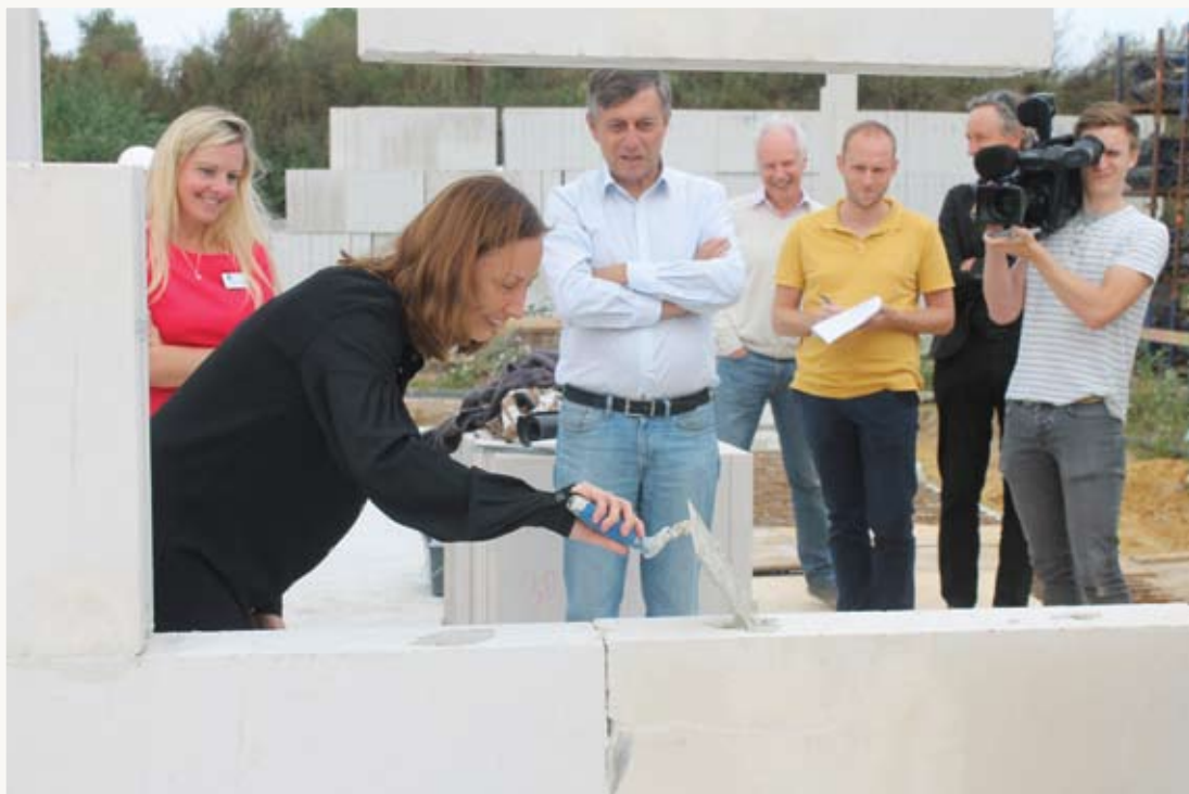
Ten kerselaere bouwt de assistentiewoning (project urban villa)
